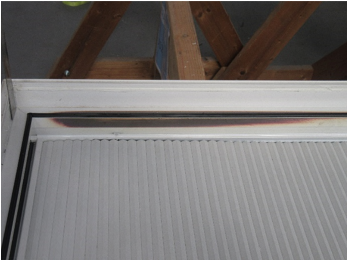
Abbildung 1 Die Verfärbung variiert von dunkelviolett im Zentrum bis zu hellviolett an den zudem gelblich verfärbten Rändern.
